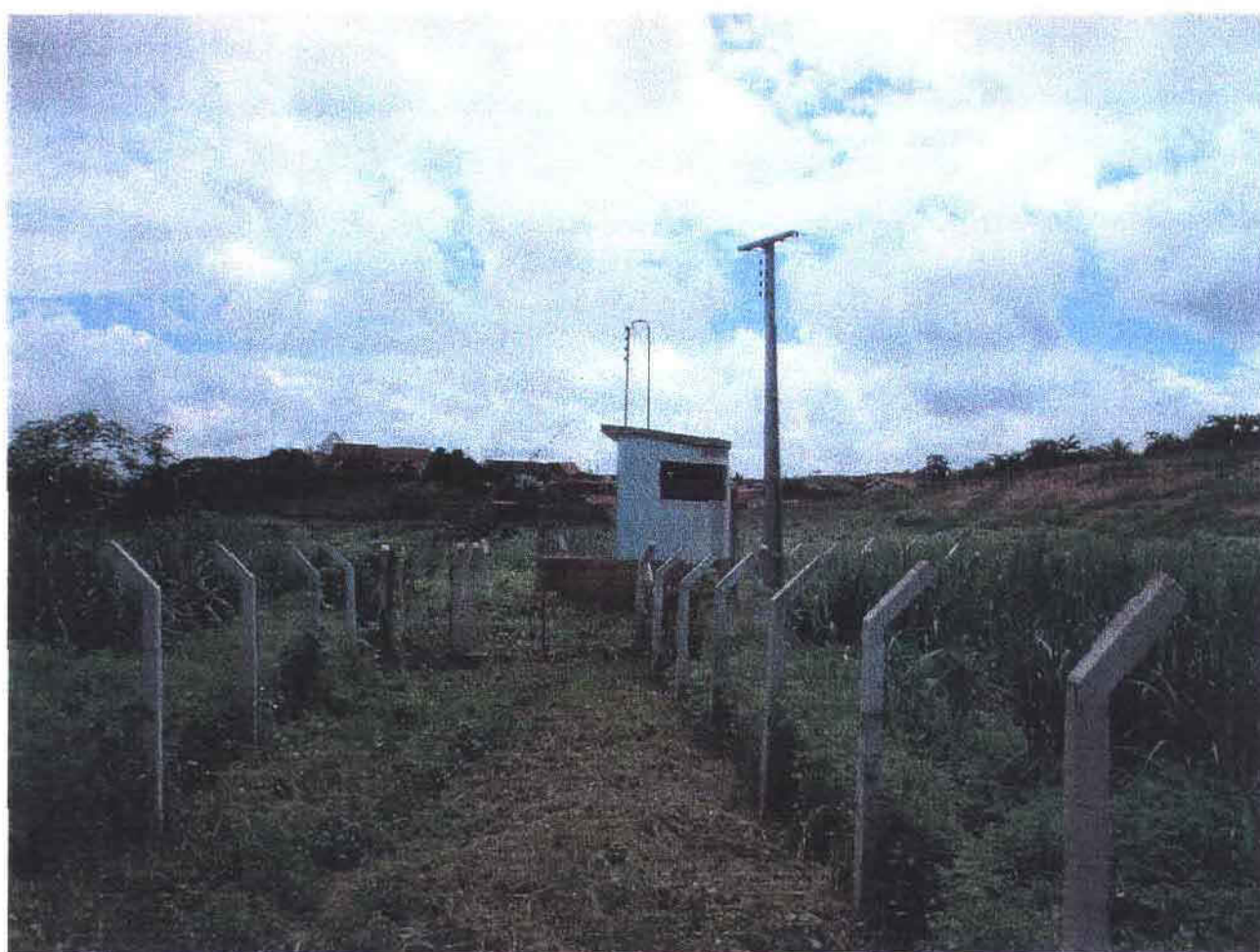
Fig.1:Captação Existente (Poço Amazonas com Bomba submersa 14,6m 3 /h)
